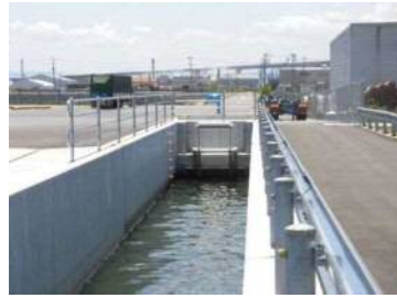
H27: 樋門改築工事 H28~R1 : 排水路改修工事
