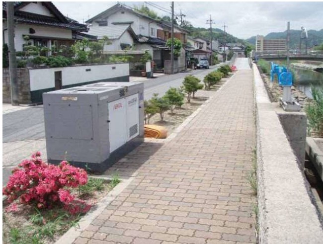
○仮設排水ポンプ（承水路側より）
