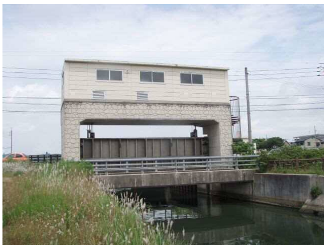
○樋門（下流から見て）
