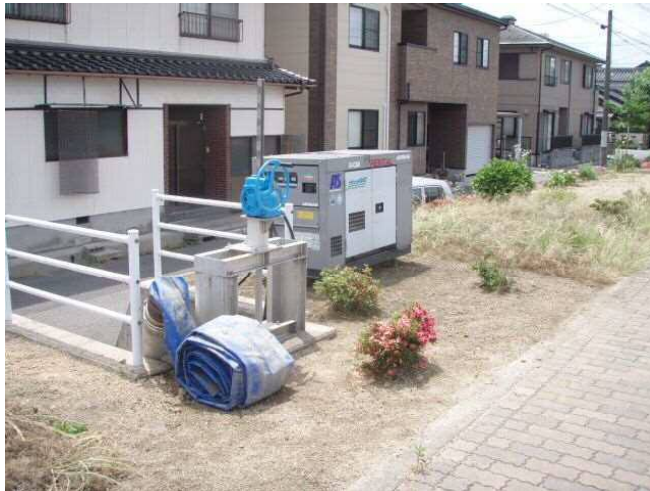
○仮設排水ポンプ（承水路側より）
