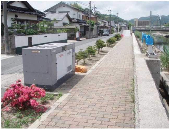
○仮設排水ポンプ（承水路側より）
