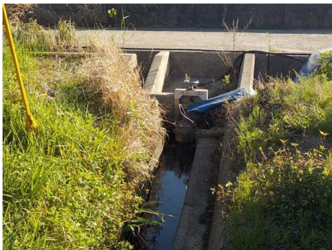
○樋門・仮設排水ポンプ①（道路側より）
