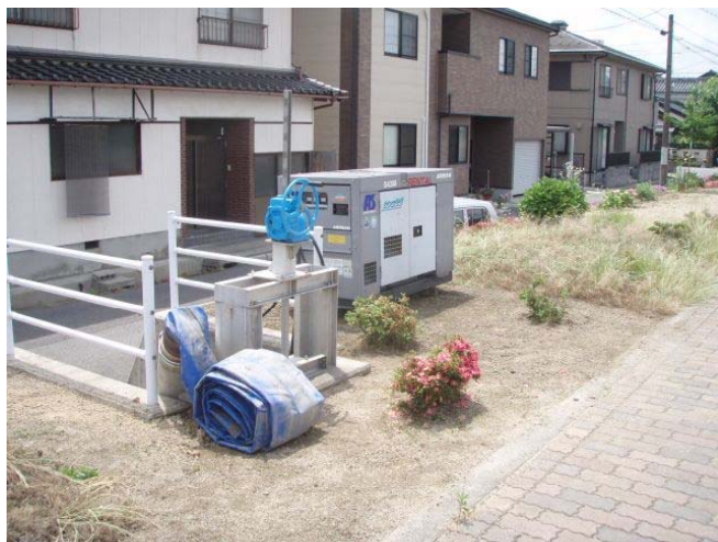
○仮設排水ポンプ（承水路側より）
