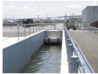
H27: 樋門改築工事 H28~R2 : 排水路改修工事
