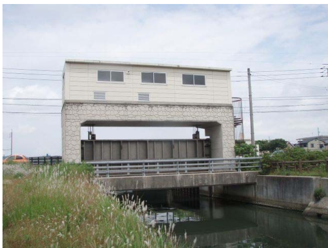
○樋門（下流から見て）
