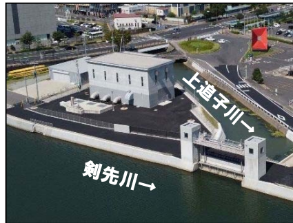
Ⓐ 上追子排水機場(R3.9完成)
