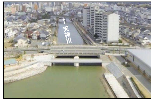
Ⓑ 天神川水門(H27.1完成)
