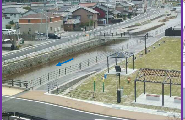
木戸川河川改修状況(事業継続中)
