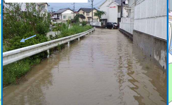
R3.7.7: 木戸川浸水状況
