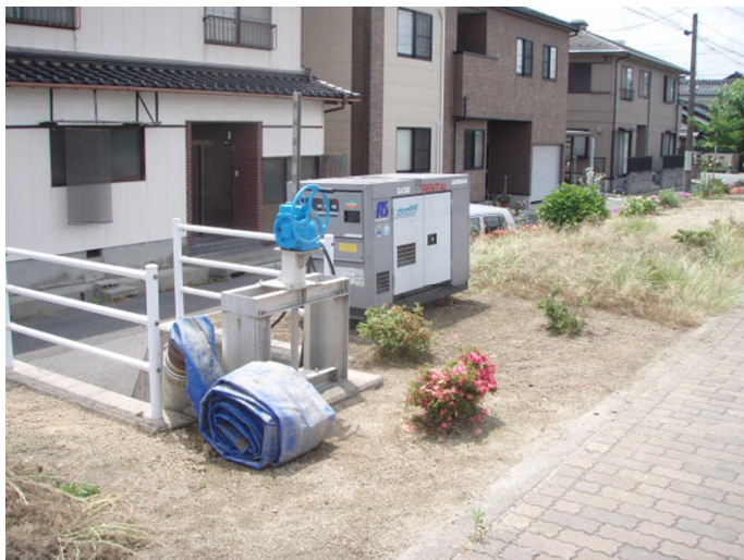
○仮設排水ポンプ①（承水路側より）
