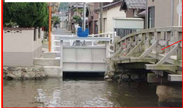
H28完了: 逆流防止ゲート完了
