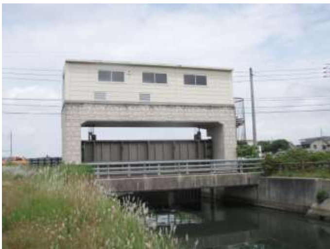
○樋門（下流から見て）
