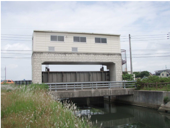
○樋門（下流から見て）
