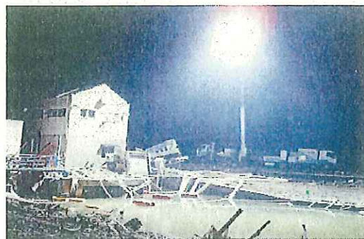
H22.4 排水ポンプ車・照明車による 津波で被災した排水機場での排水支援 (宮城県本吉郡七ヶ浜町)
