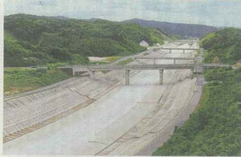
完成した斐伊川放水路。洪水時には最大で毎秒2千トンを斐伊川から神戸川に流す。出雲市上塩治町
