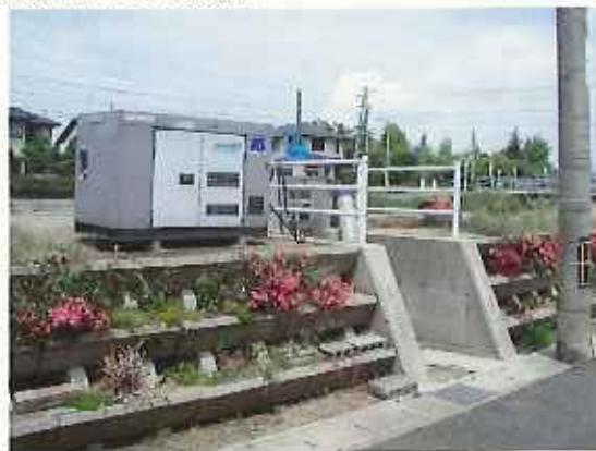
仮設排水ポンプ(南側)
