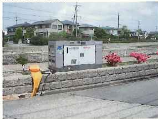
仮設排水ポンプ(南側)
