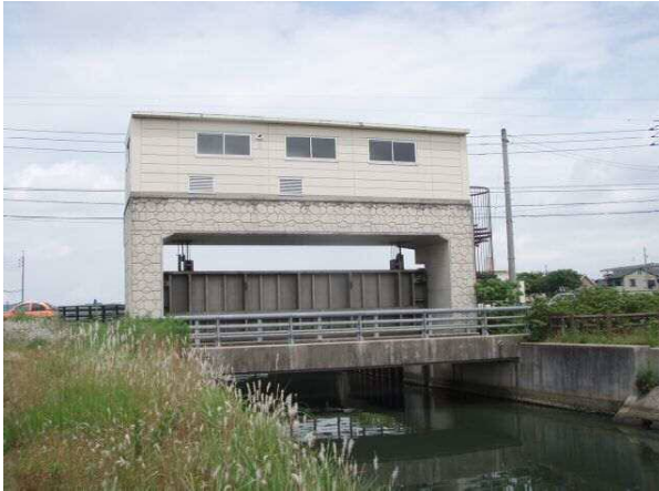
樋門(下流側から見て)
