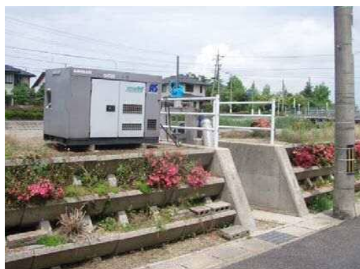
仮設排水ポンプ(南側)
