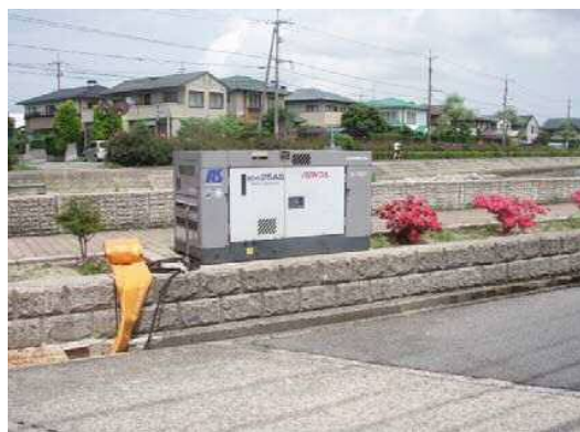
仮設排水ポンプ(南側)
