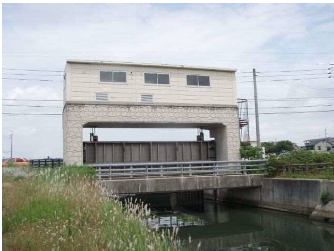
○樋門（下流から見て）
