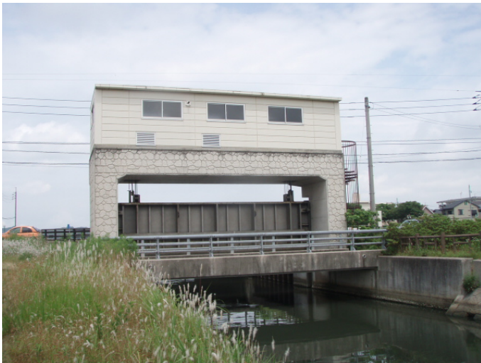
○樋門（下流から見て）
