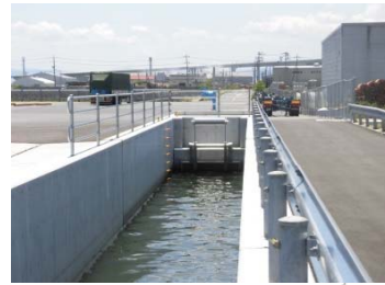
H27 樋門改築工事 H28～排水路改修工事
