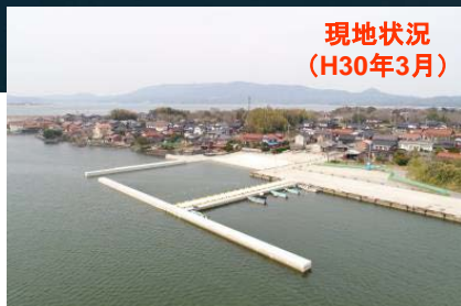
現地状況 (H30年3月)
