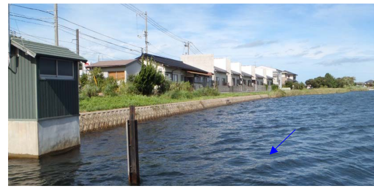
②中流部のブロック護岸(矢田の渡しより望む)
