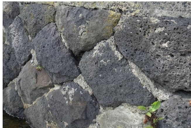
新大橋下流北岸・石積アップ 石は不整形で、表面の凹凸が大きく、目地が深く陰影に富んでいる。老朽化に伴いモルタルで目地補修が行われている箇所も多い。施工時には深目地としながらも、胴込めコンクリートが露出しないように配慮することが必要
