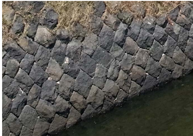
松江大橋下流北岸 ・石在の形状や大きさがマチマチで、ブロック積みと比べ豊かな表情が現れている。
