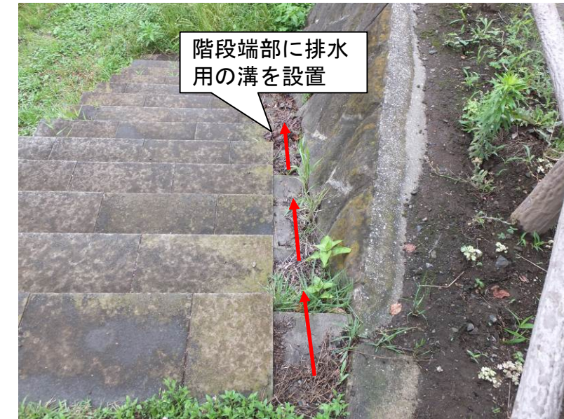
階段端部の排水溝の例
