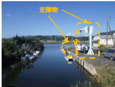
(右岸)船揚場【船着き場及び引揚げクレーン】 (左岸)駐車場
