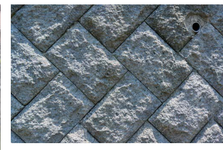
■レベル1-2：表面はつり出しブロック 人工的な面取り部をはつり落とした製品
