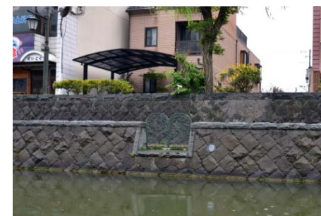
■レベル2：自然石（安山岩系） 京橋川・カラコロ広場付近の御崎石。
