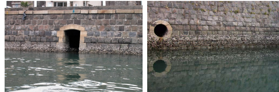
写真5 きちんとデザインされた排水口(横浜堀割川:震災復興護岸)
