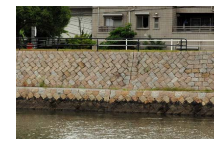
写真17 目地材が表面に出ないように
