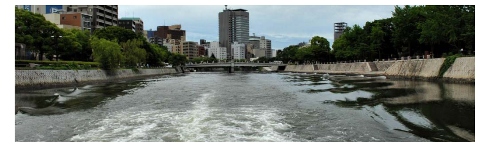
写真9 太田川(広島市)。写真右は階段によって護岸が分節され、景観的なメリハリがきている。写真左は一般的な護岸が連続している。
