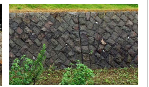
写真18 護岸材と同じ処理を施す
