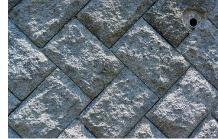
写真1：谷積護岸(愛知県伊賀川)
