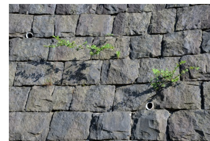
写真16 練石積：深目地仕上げ（同左）
