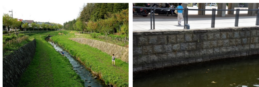
写真1 天端コンクリートを打たずに土で埋戻し、植栽で和らげている事例
