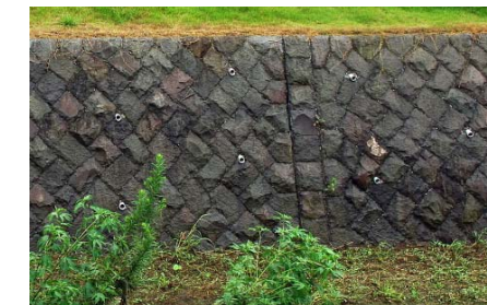
写真10 護岸と同様のテクスチャー
