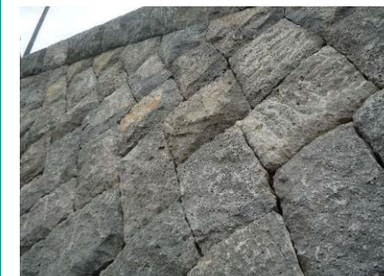
写真10 大橋川向島地区
