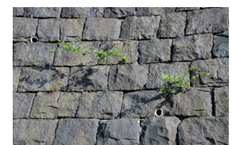
写真15 練石積：深目地仕上げ（同左）
