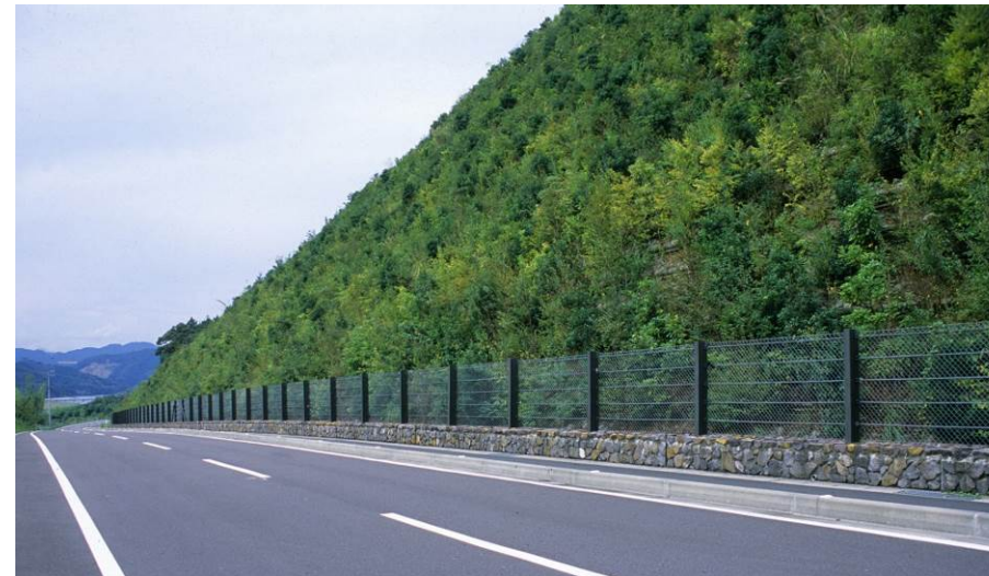
木の香る道事業（高知県）：道路拡幅で削った斜面に ようびょう 幼苗を植栽して樹林を復元する。
