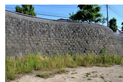
写真14 練石積：深目地仕上げ
