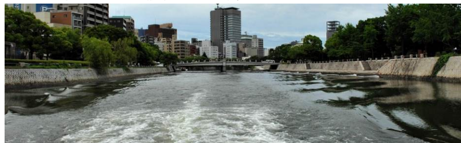
写真5 太田川（広島市）。写真右は階段によって護岸が分節され、景観的なメリハリがきいている。写真左は一様な護岸が連続している。
