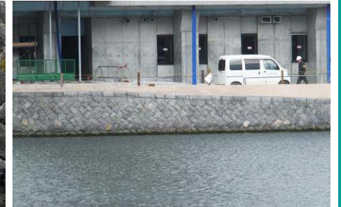
写真9 大橋川向島地区
