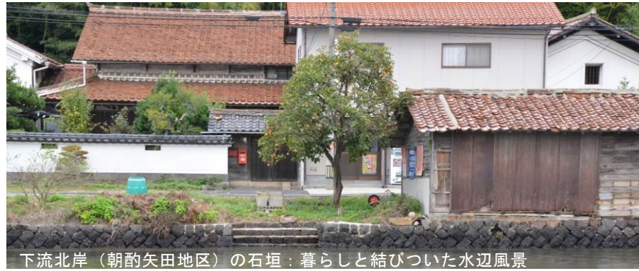
松江大橋下流北岸：雑割石積。ヤナギ並木。老舗旅館。松江の風情を継承する
