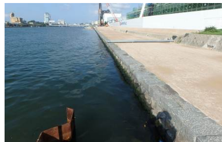
写真3 天端石による天端処理（向島地区）
