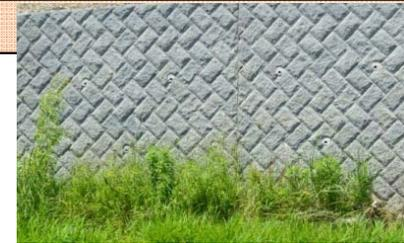
伸縮目地が護岸表面に露出していない状況
