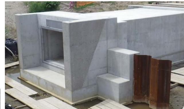
樋門コンクリート面表面を洗い出し処理により明度を落とした（福富地区）
