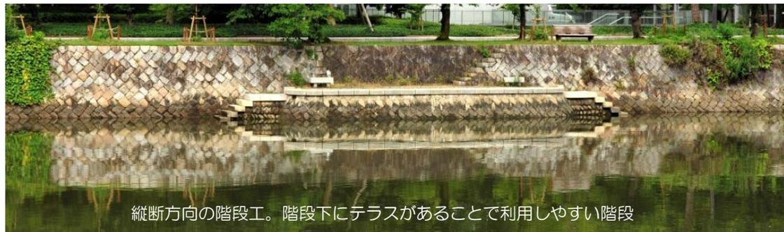
縦断方向の階段工。階段下にテラスがあることで利用しやすい階段
