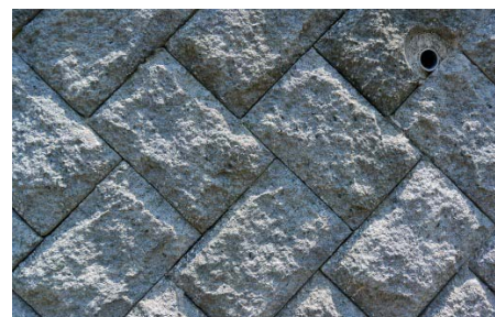
■素材1-2: 表面が石材に近い質感のコンクリートブロック 人工的な規則性があまり感じられない。
