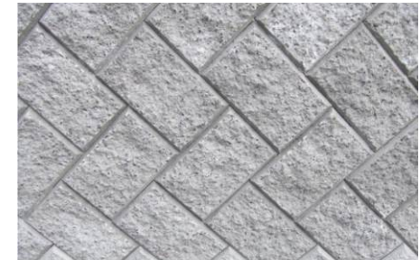
■素材1-1: 従来型の景観配慮タイプのコンクリートブロック 表面にざらつきや凹凸があり明度が低い。
