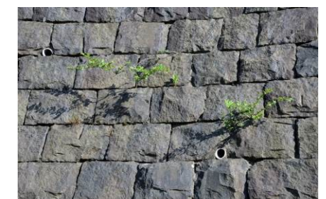
写真15 練石積：深目地仕上げ（同左）
