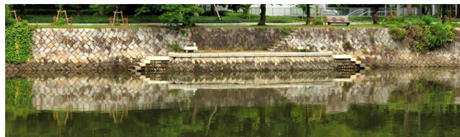
写真4 縦断方向の階段工。階段下にテラスがあることで利用しやすい階段。
