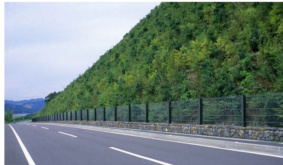
木の香る道事業（高知県）：道路拡幅で削った斜面に ようびょう 幼苗を植栽して樹林を復元する。
