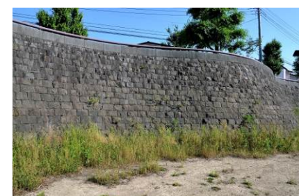
写真14 練石積：深目地仕上げ
