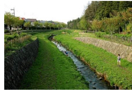
写真1 天端コンクリートを打たずに土で埋戻し、植栽で和らげている事例
