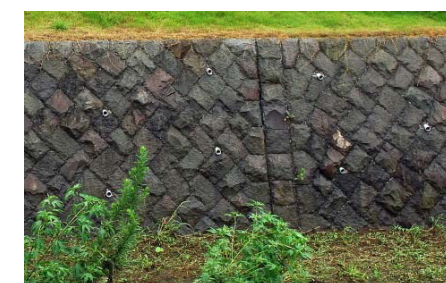
写真10 護岸と同様のテクスチャー
