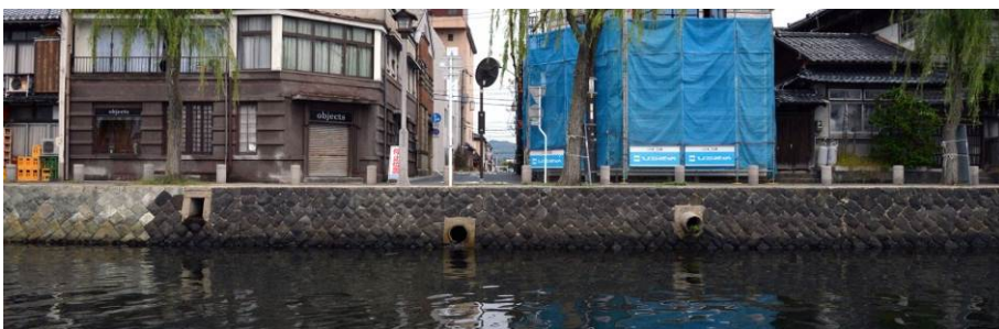
写真8 無造作に取り付けられた排水口(大橋川)
