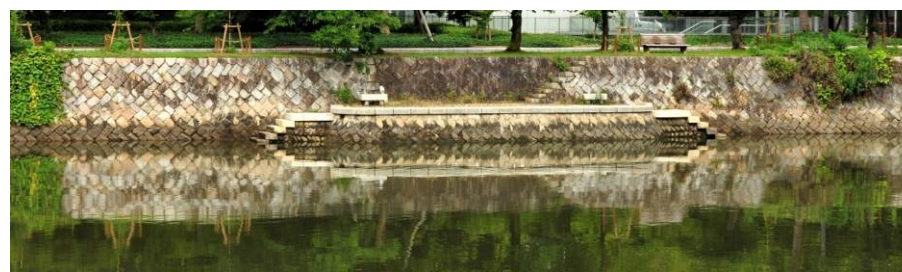
写真4 縦断方向の階段工。階段下にテラスがあることで利用しやすい階段。
