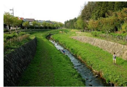
写真1 天端コンクリートを打たずに土で埋戻し、植栽で和らげている事例
