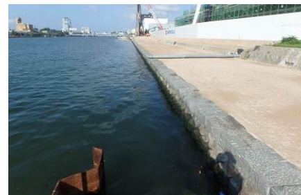
写真3 天端石による天端処理(松江地方合同庁舎前)
