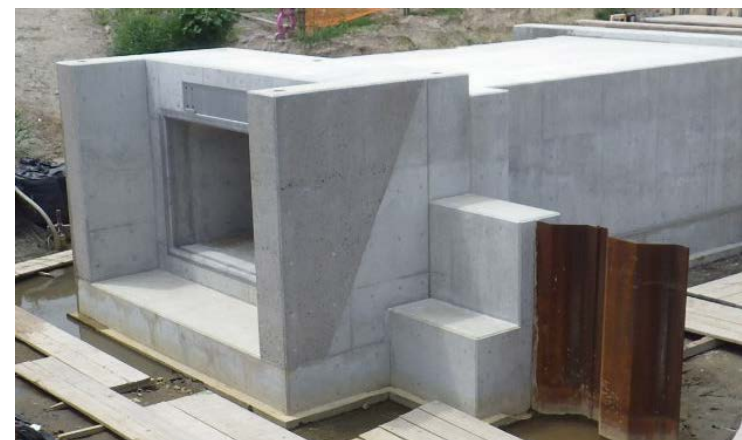
写真9 樋門コンクリート表面を洗い出し処理により明度を落した(福富地区)
