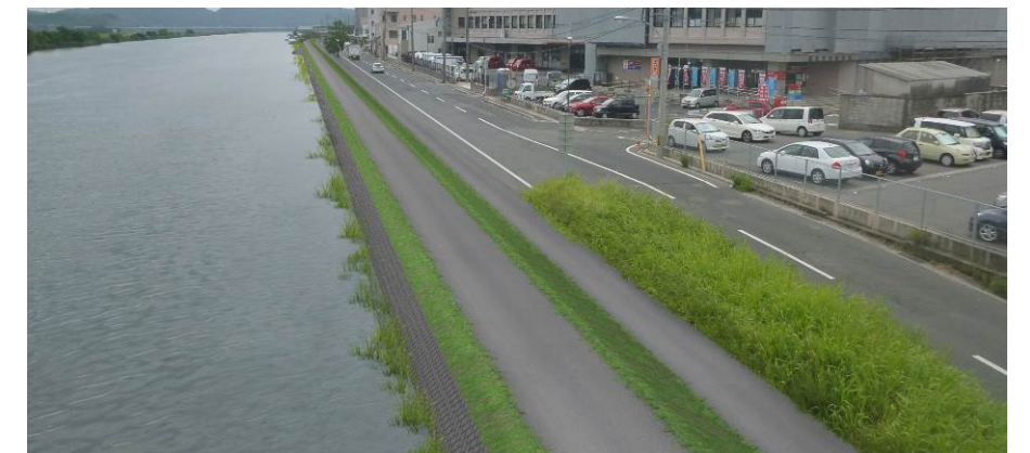
図3 一様な護岸が連続し、水との関わりが持てない。(中流南岸イメージ図)
