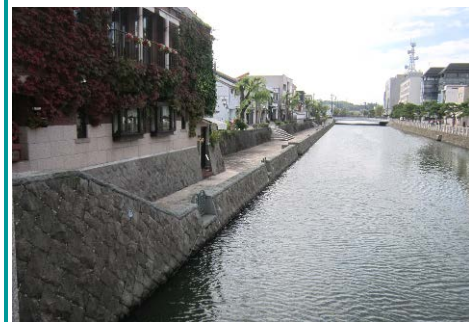
写真1 カラコロ広場前京橋川護岸
