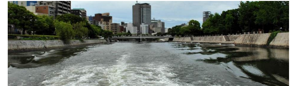
写真5 太田川(広島市)。写真右は階段によって護岸が分節され、景観的なメリハリがきている。写真左は一様な護岸が連続している。
