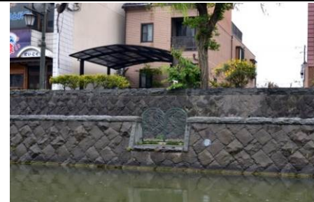
■素材2: 自然石(安山岩系を基本とする) 京橋川・カラコロ広場付近の安山岩護岸。
