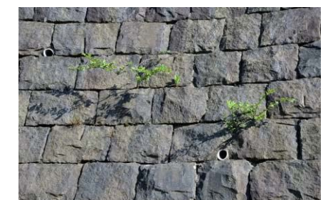
写真15 練石積：深目地仕上げ（同左）
