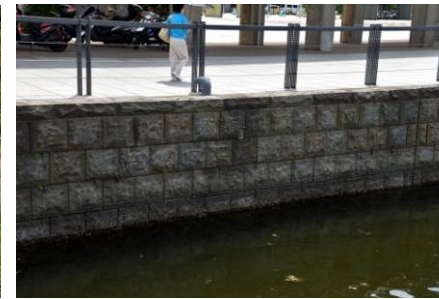
写真2 天端に笠石を置き舗装と法肩部を明示すると共に一体的にデザインした事例
