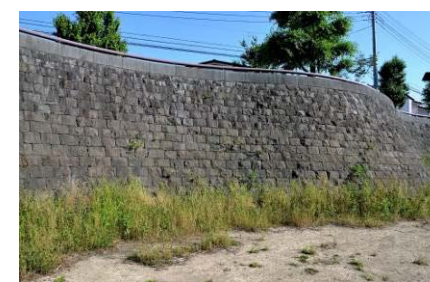
写真14 練石積：深目地仕上げ
