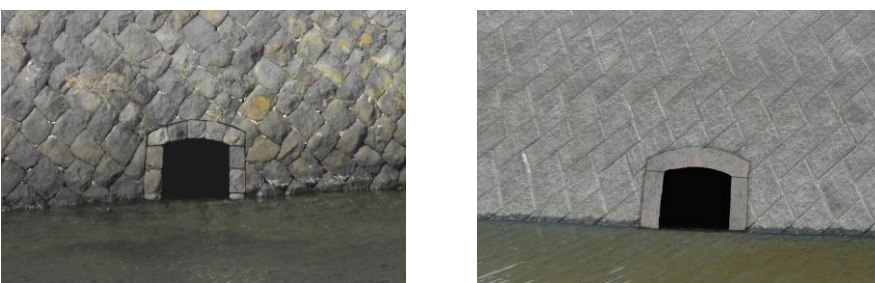
図7 護岸と一体的なデザインのイメージ例(左:自然石、右:ブロック積)
