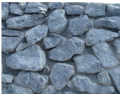
写真：伯太安山岩による奥目地仕上げ
