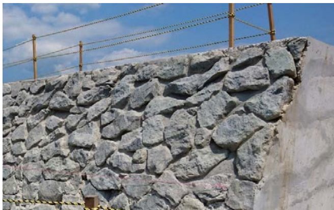
写真：伯太安山岩による割石積
