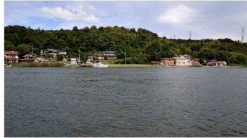
矢田の渡し付近：河道拡幅により地形が改変される。
