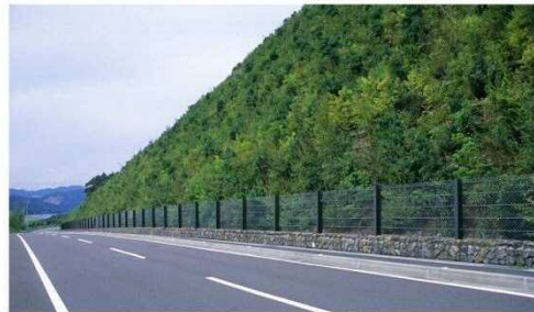
木の香る道事業（高知県）：道路拡幅で削った斜面に幼苗を植栽して樹林を復元する。
