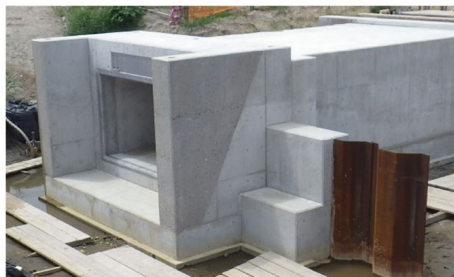
樋門コンクリート表面を洗い出し処理により明度を落した（福富地区）
