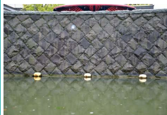
写真1 カラコロ広場前京橋川護岸
