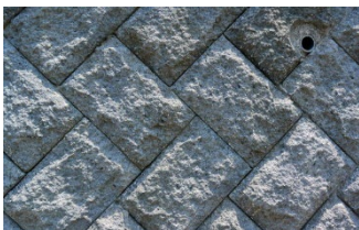
写真1：谷積護岸(愛知県伊賀川)
