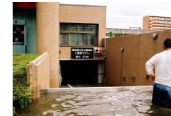
平成18年7月出水 松江市内(朝日町)の浸水状況
