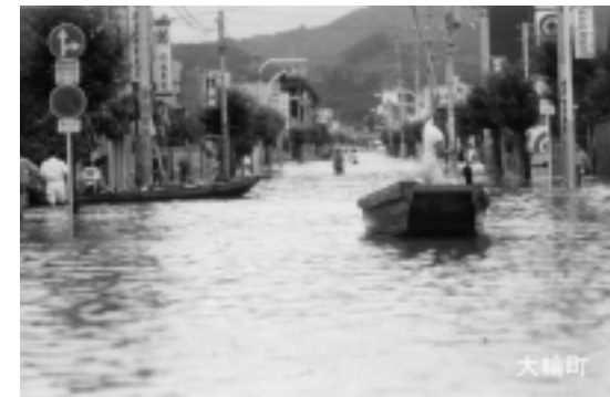
昭和47年7月出水 松江市内(大輪町)の浸水状況 出典：松江市役所所有 資料
