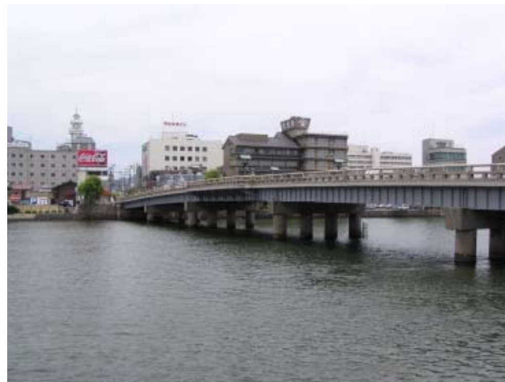
〔上流右岸より松江大橋を望む〕
