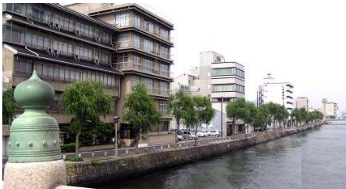
〔松江大橋より下流左岸側〕
