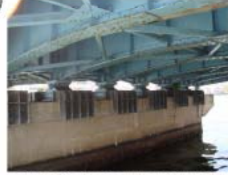
橋脚支番部(支点の落橋対策:H3年既施工状況)
