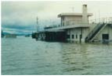
昭和47年7月出水 出雲空港の浸水状況(10日間閉鎖)
