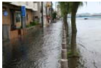
大橋～新大橋 北岸
