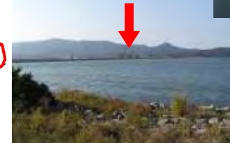
森山堤防開削場所
