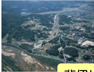
斐伊川放水路
