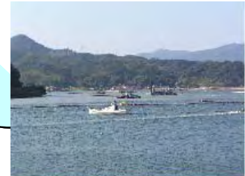
本庄水域西部承水路堤防 撤去状況 (2007.10)
