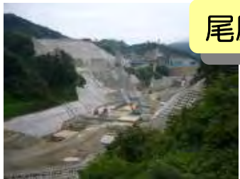
尾原ダム本体工事 進捗状況 (2007.10)
