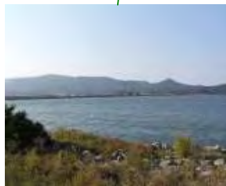
本庄水域西部承水路堤防撤去状況 (2007. 10)
