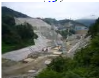
尾原ダム本体工事進捗状況 (2007. 10)
