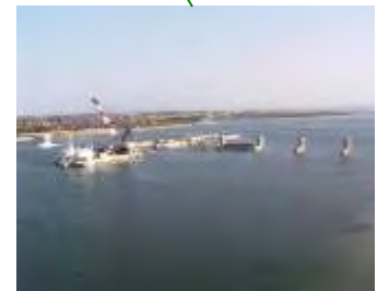
中浦水門撤去状況 (2007. 10)
