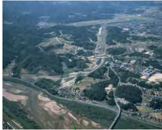
斐伊川放水路工事進捗状況 (2007. 9)
