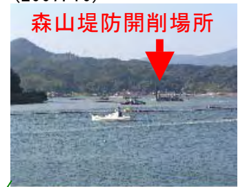
森山堤防開削状況 (2007. 10)
