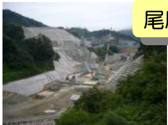
尾原ダム本体工事 進捗状況 (2007.10)
