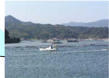
本庄水域西部承水路堤防 撤去状況 (2007.10)
