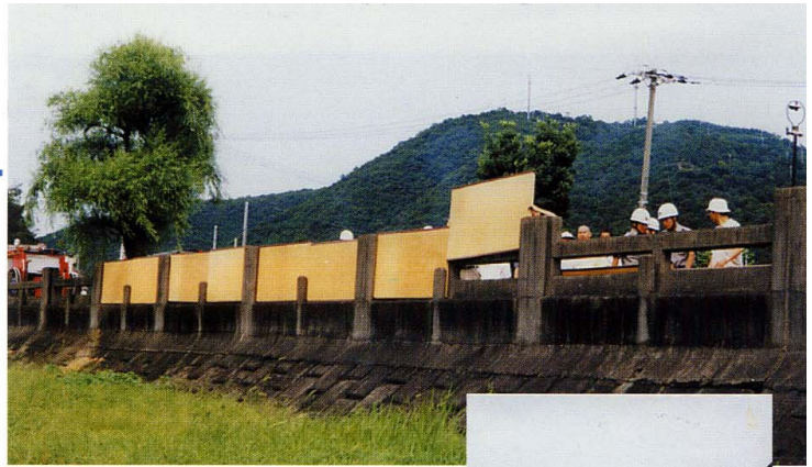
設置から50年。初の畳堤を使った水防訓練を行った消防隊員たち
