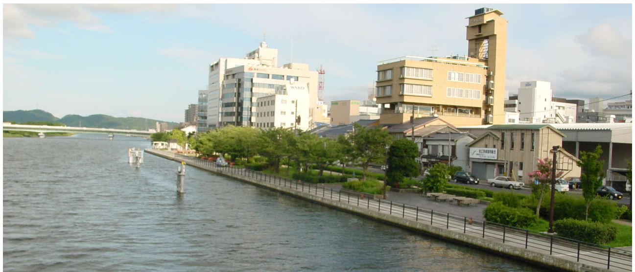
新大橋より下流方向右岸側を望む
