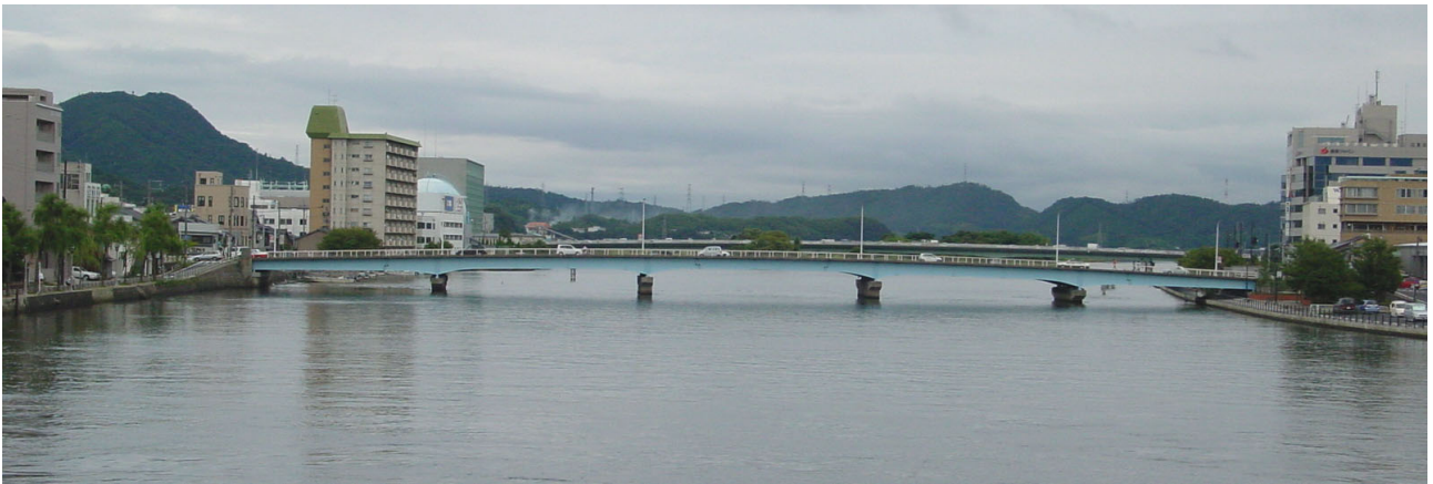
大橋より下流方向を望む
