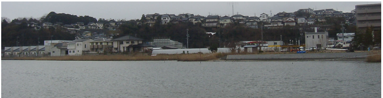
朝酌川合流点付近（大橋川を航行する船上）より右岸側を望む
