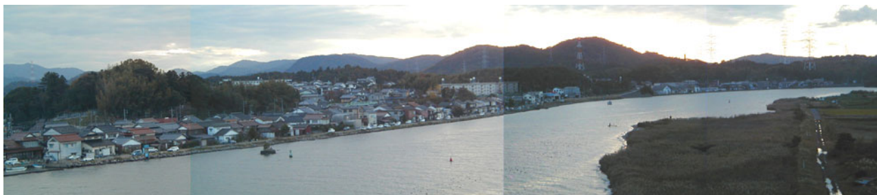
中海大橋より上流方向を望む
