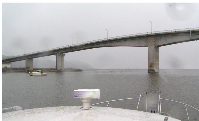
中海大橋上流 500m 付近より下流方向を望む
