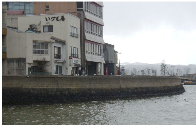
宍道湖大橋～大橋中間地点より右岸側を望む
