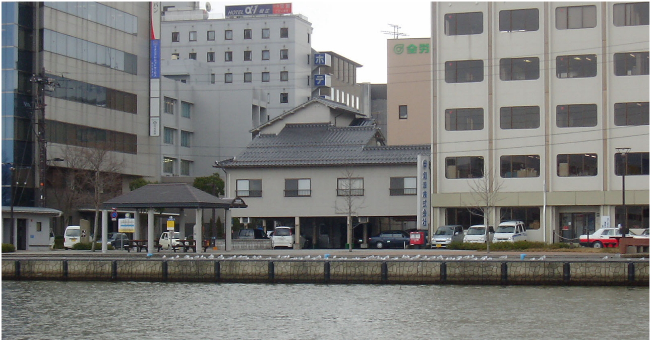
くにびき大橋付近より右岸側を望む
