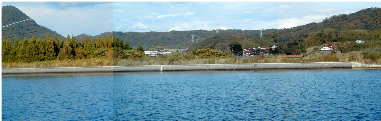
朝酌川合流点上流側 300m 付近より対岸を望む
