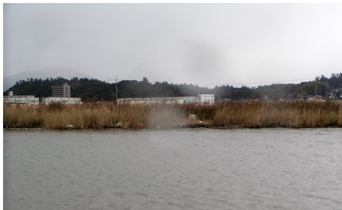
くにびき橋下流 500m 付近より左岸側を望む
