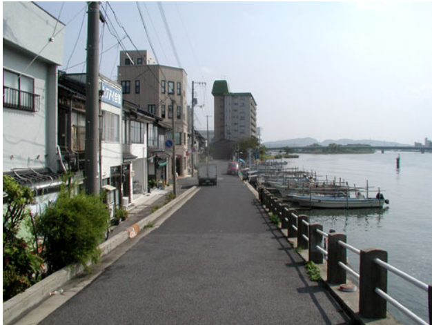
新大橋北詰より下流方向左岸沿いを望む
