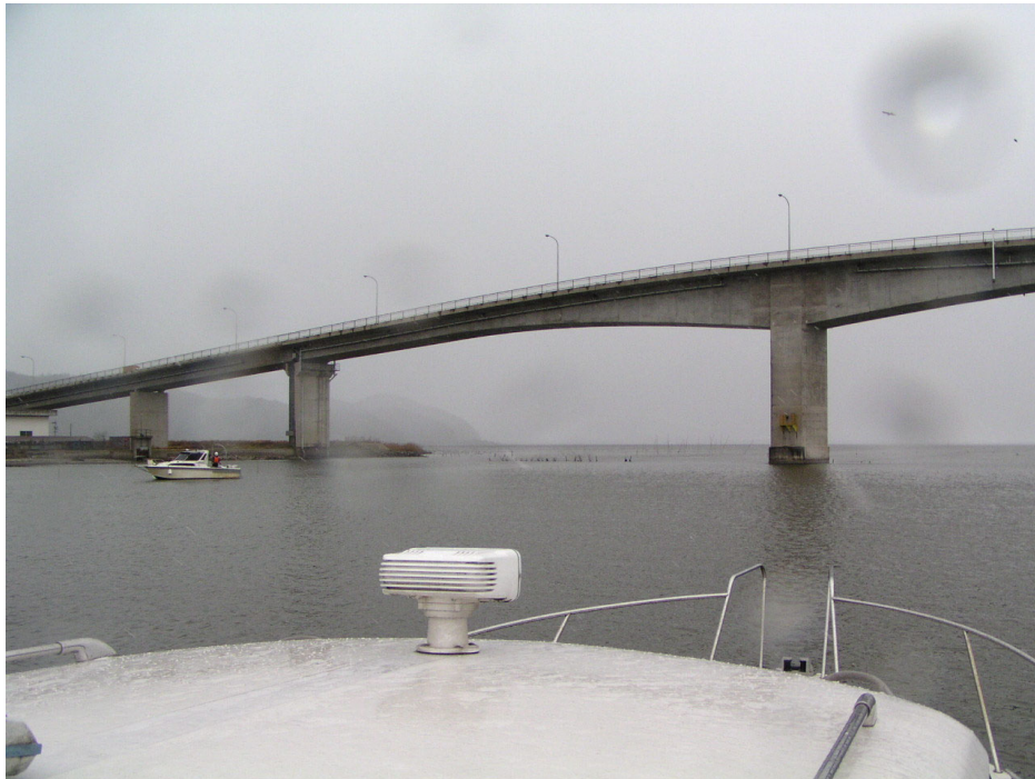
中海大橋上流500m付近より下流方向を望む
