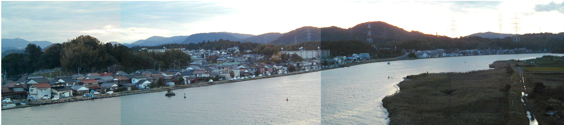
中海大橋より上流方向を望む
