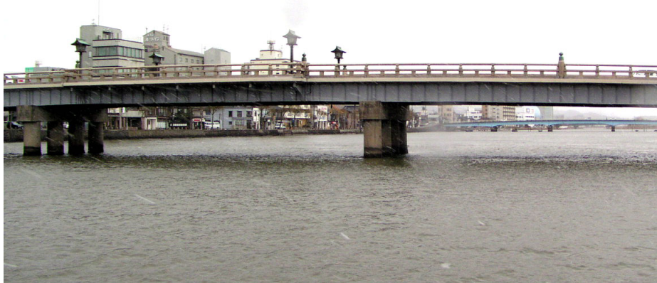
宍道湖大橋～大橋中間地点より下流方向を望む
