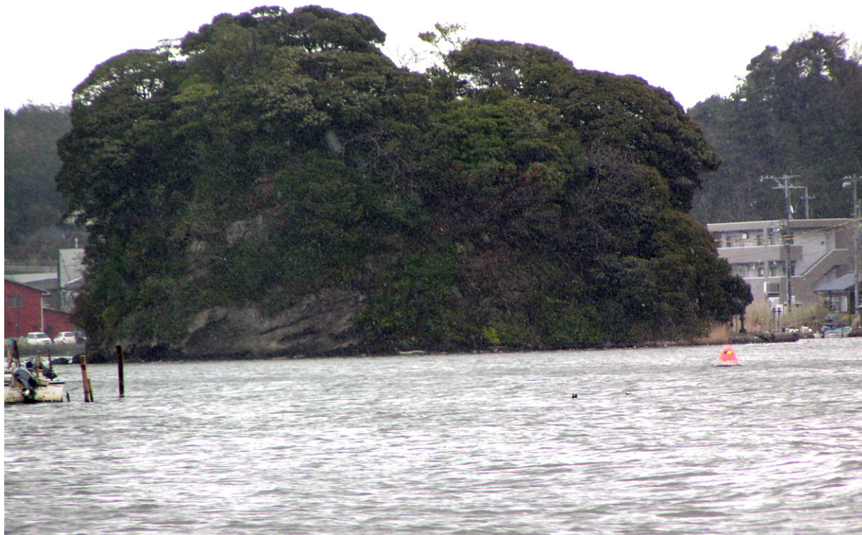
塩楯島上流400m付近より下流方向を望む
