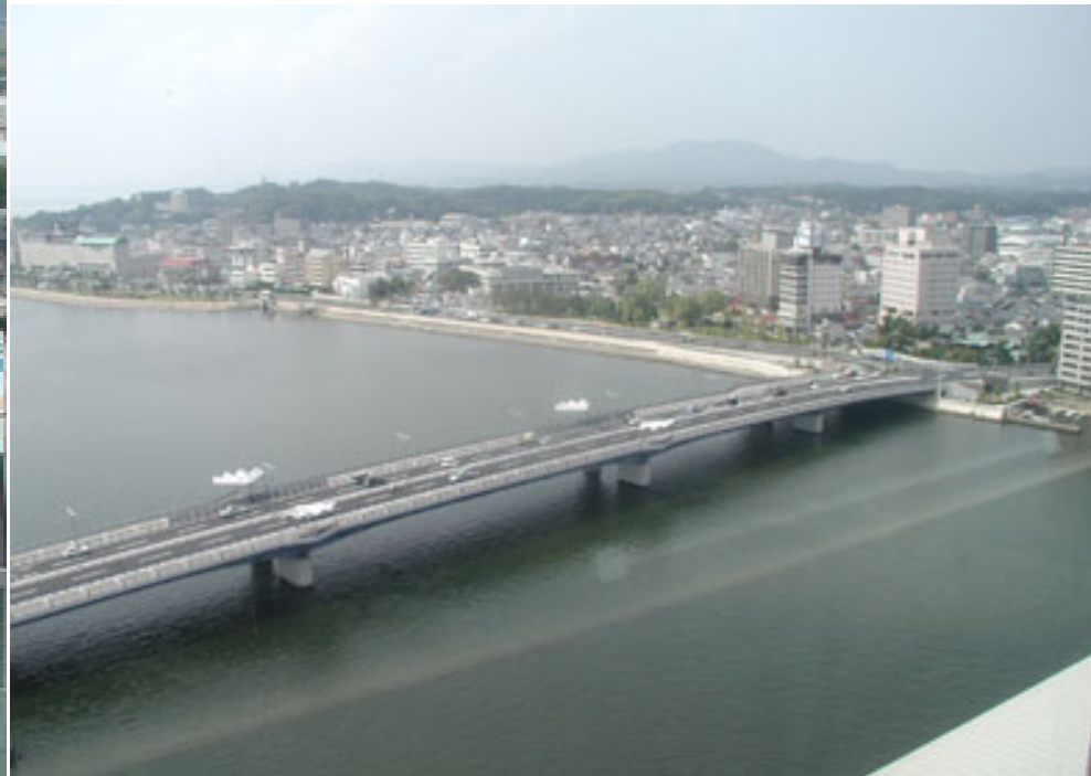
山陰合同銀行より上流方向(呑口付近)を望む
