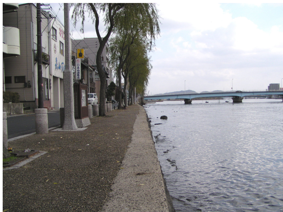
大橋北詰より下流方向左岸沿いを望む
