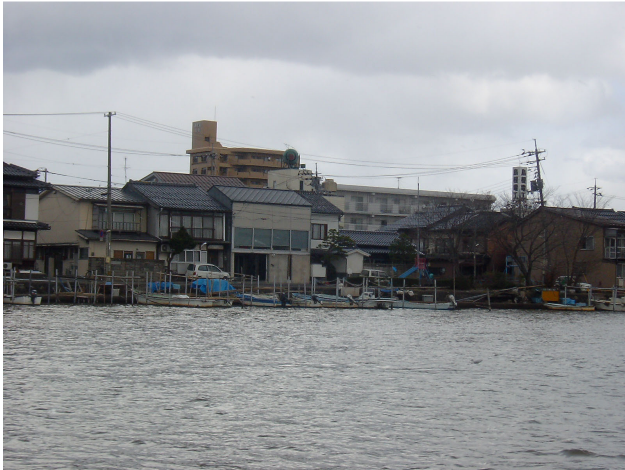
くにびき大橋付近より左岸側を望む
