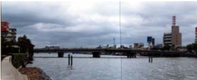
昭和 55 年頃の大橋（宍道湖よりの全景）
