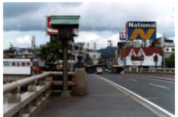
昭和 55 年頃の大橋 （橋の中央部張り出し（眺望スペース））
