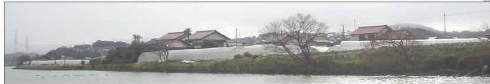
・大橋川右岸(南岸) 朝酌川合流点上流側300m付近
