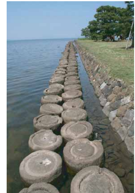
・来待石でつくられた「如泥石」は、消波機能だけでなく、水際への近づきやすさ、景観性を備え、松江らしさを感じさせる素材となる
