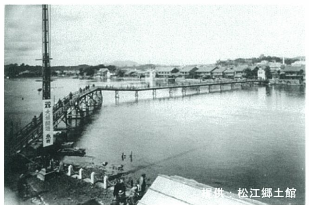
(第17代大橋架橋の際の仮橋)
