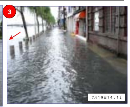
新大橋上流【左岸7 / 000付近】
