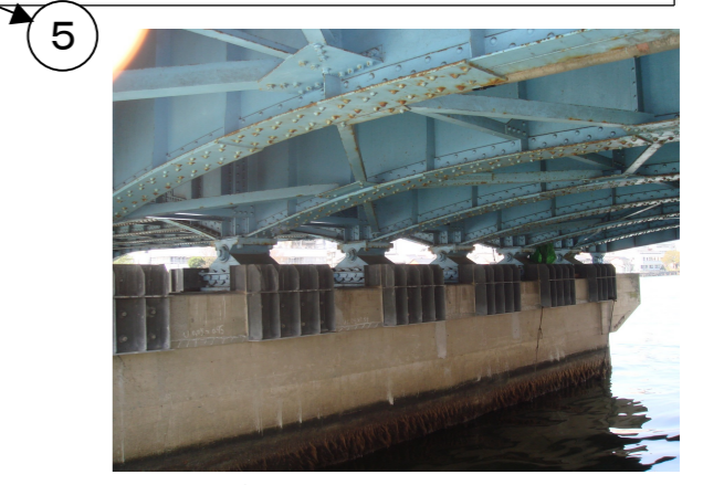
橋脚支部(支点の落橋対策:H3年既施工状況)
