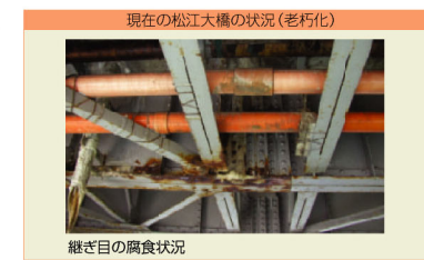
継ぎ目の腐食状況
