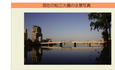
現在の松江大橋の全景写真
