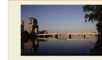
現在の松江大橋の全景写真
