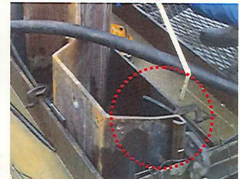
緩衝材を設置し、接触音を低減
