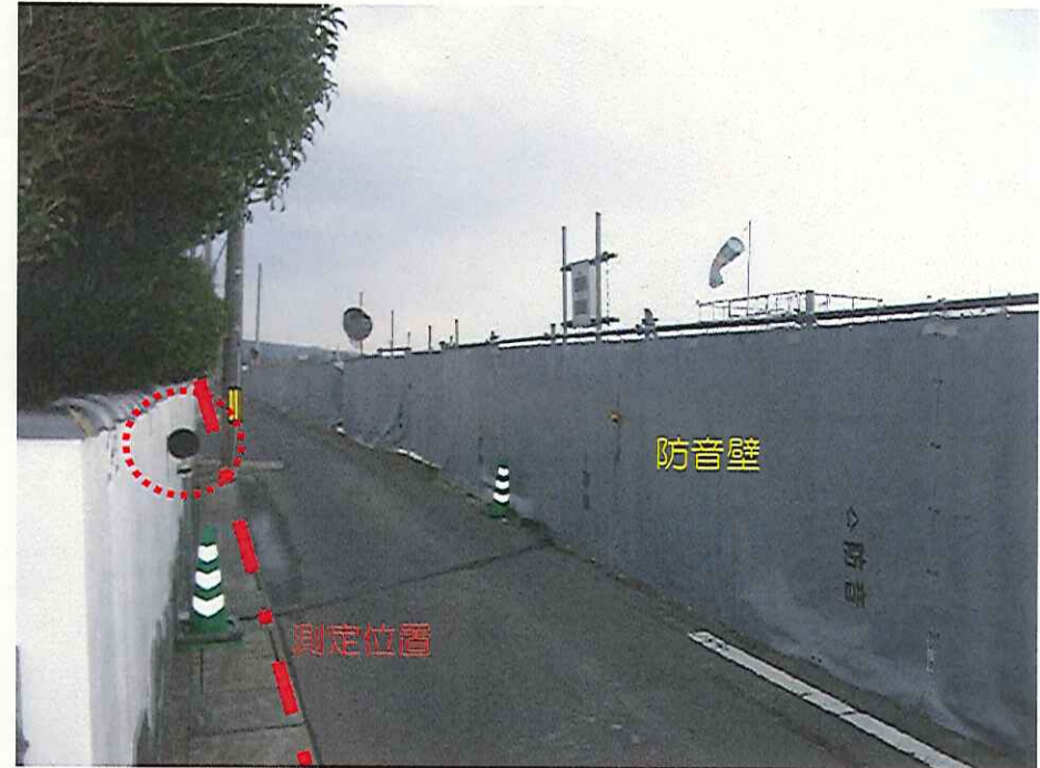
測定は矢板・施工に最も近い民家近傍の堤防道路
