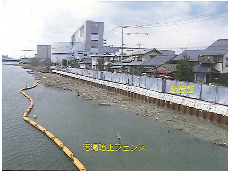
川側：環境対策状況
