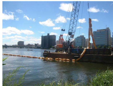
汚濁防止フェンス設置状況
