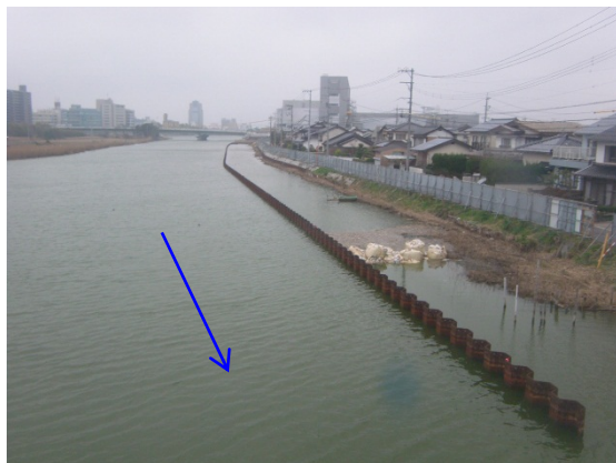
工事着手前 (平成25年3月)
