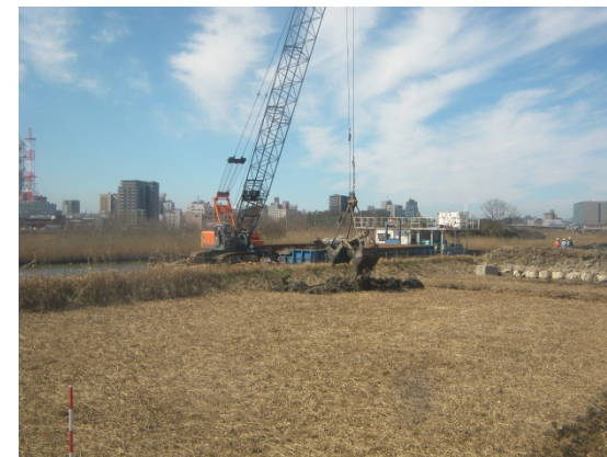
仮置作業 (平成25年3月)
