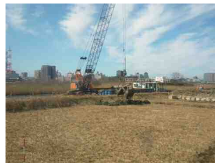
土砂仮置場への 仮移植作業 (H23. 11)
