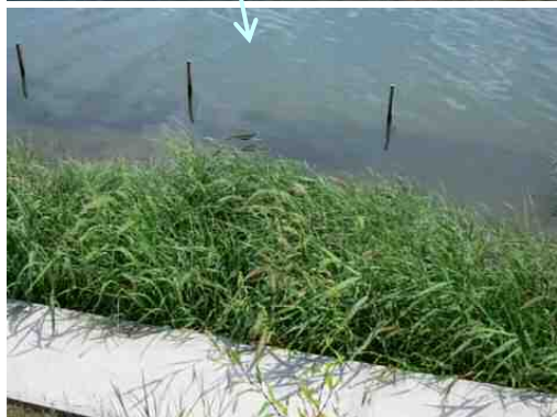
施工後8ヶ月 (H26. 6)
