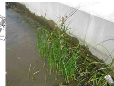
護岸周辺での ヨシ植生状況 (図中青線箇所)
