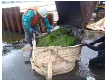
移植作業状況
