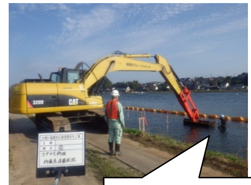
移植先の基盤を掘り下げ
