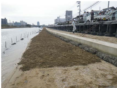
播き出した砂泥を厚さ3cm程度に均等に敷き均し完成
