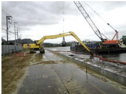
追子地区護岸前面への 再移植作業 (H25. 10)
