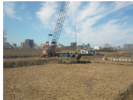
土砂仮置場への 仮移植作業 (H23. 11)
