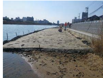
竹串により植生ネット を固定
