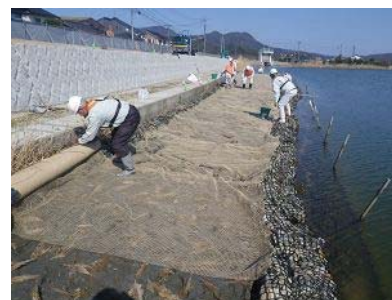
植生ネットを敷設
