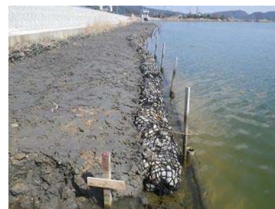
泥質土の撒きだし、 ネット蛇籠の敷設
