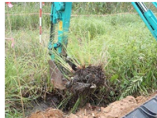
法面バケットによる採取(剥ぎ取り厚15cm)
