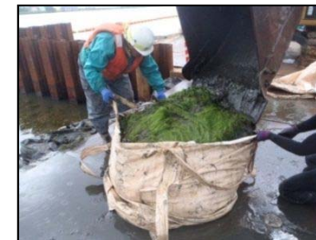
土のう（手作業）
