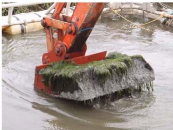
改良バケットによる移植状況
