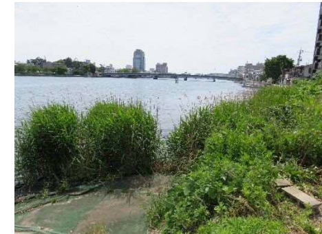
施工箇所状況(上流側)
