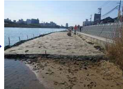
竹串により植生ネット を固定
