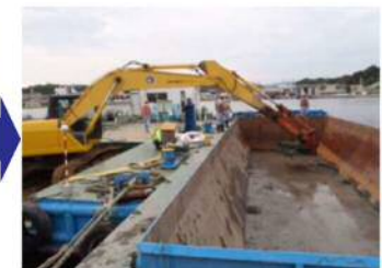
土運船へ移し入れ
