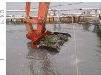
移植先へ基盤を 設置
