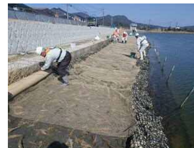
植生ネットを敷設
