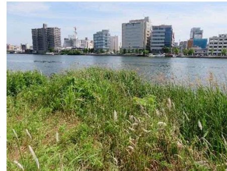
施工箇所状況(下流側)
