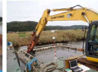
③移植先へ基盤を設置
